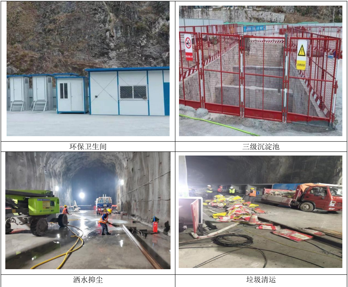
图 3-1 施工期环保措施
